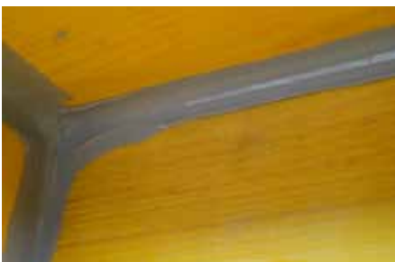
6. Etendre/égaliser la colle dépassant après s'être enduit les doigts de savon liquide.
