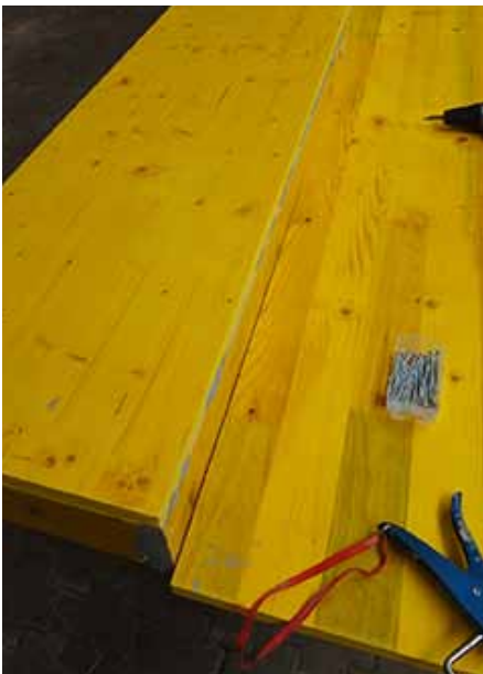
5. Fond collé avant la pose des vis.
