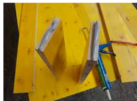
2. Application de colle sur la tranche.
